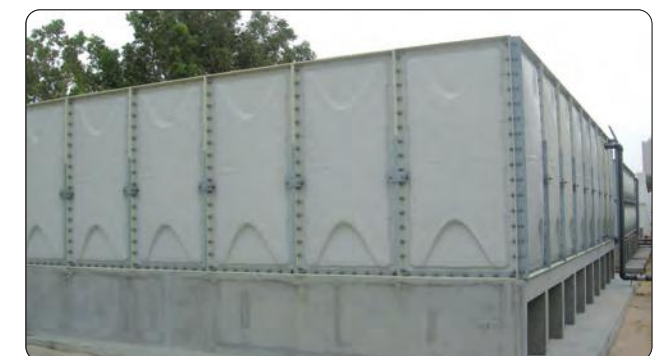
Tank Size 7m x 9m x 2mH : 126 Ton
